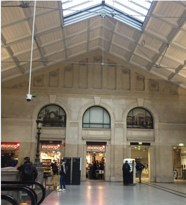
Fig. 6. Tympan côté de la cour de Rome après de l'opération « Demain Saint-Lazare ». © Anne Ridao-Tardif, le 6 juin 2020.
