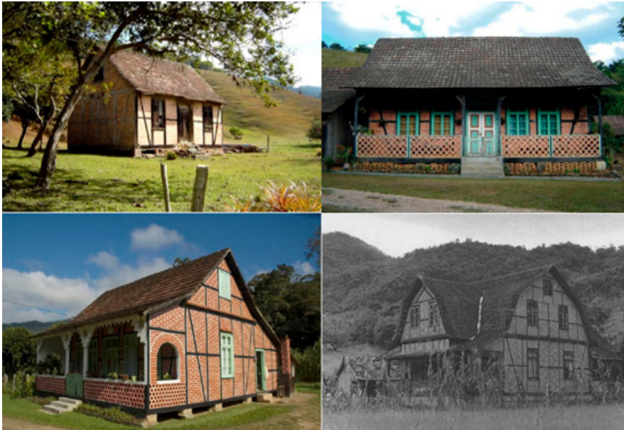
Fig. 1. L'adaptation de la technique du colombage au Brésil. Source : Instituto do Patrimônio Histórico e Artístico Nacional, Roteiros Nacionais de Imigração, vol.2, s.l., 2011.
