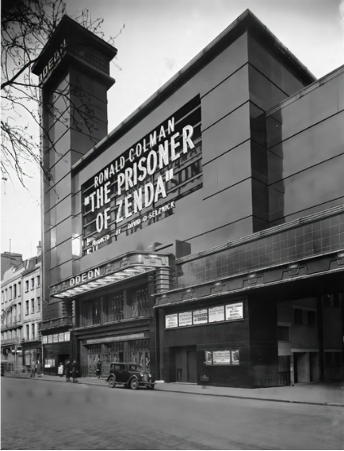
Fig. 2. Andrew Mather, Harry W. Weedon (arch.), ODEON Leicester Square, Londres, 1937, vue de 1937. © Photographie, Rank Corp. Ltd/J. Maltby Ltd, Londres, 1937, dans Francis Laclouche, Architectures de cinémas , Paris, éd du Moniteur, 1981, p. 75, ill. 109.
