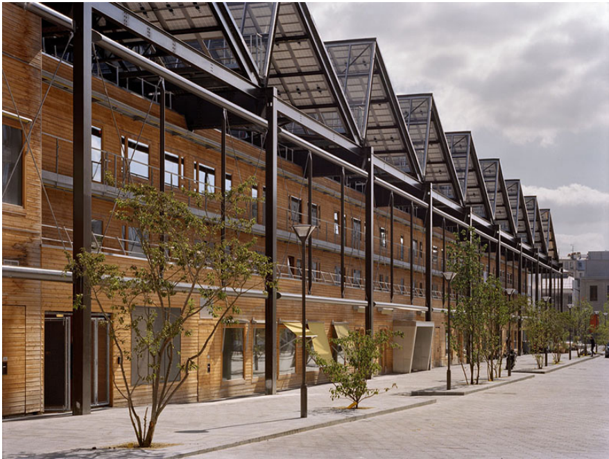
Fig. 3. Façade Ouest de la halle Pajol depuis l'esplanade Nathalie-Sarraute, © JAP.
