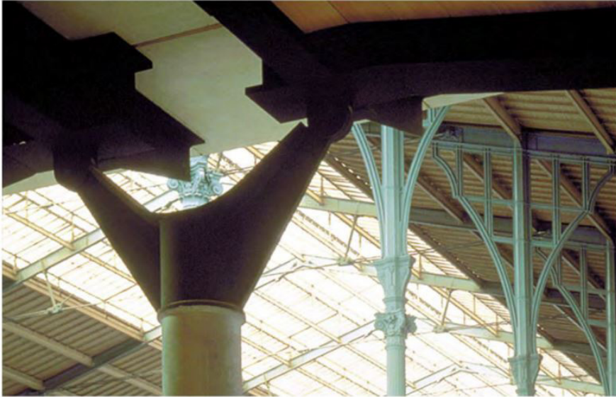
Fig.1. SNCF Gares & Connexions; AREP, J.-M. Duthilleul, E. Tricaud, Les piliers soutenant la mezzanine, 1993, Direction de Paris Nord (SNCF). © Dossier de presse AREP, Gare TGV ParisNord.
