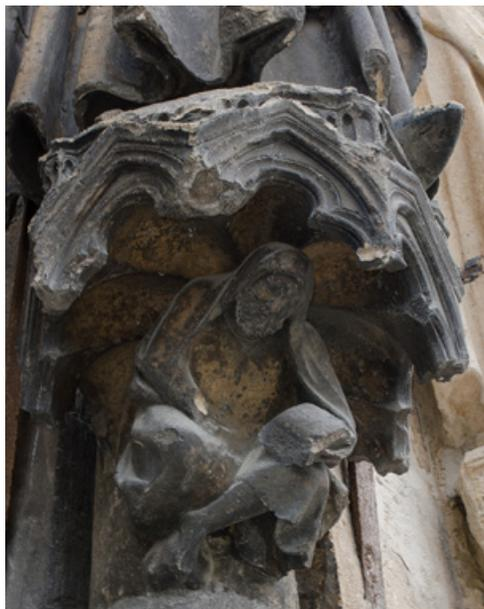
total isole le dos du marmouset de l'intrados du dais-console, annulant le rôle mécanique de cet élément (**fig. 8**).
