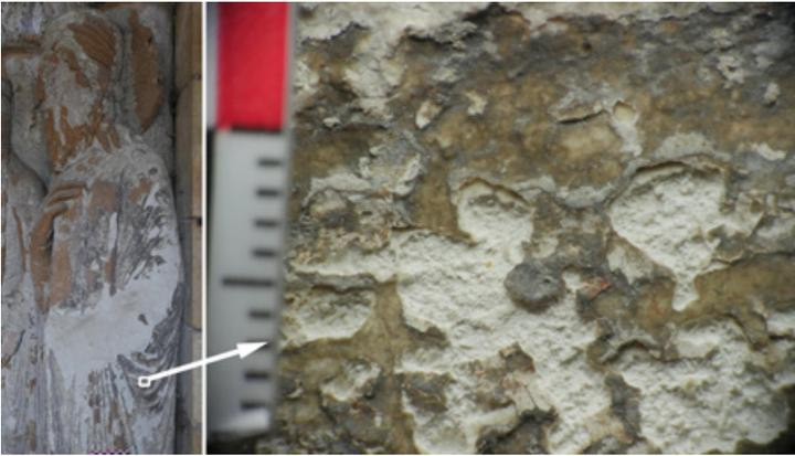
**Fig. 6.** Statue-colonne extérieure de l'ébrasement senestre : tuffeau fragilisé par les sels, laissé en partie couvert de croûtes noires après un essai de microsablage en 2009 qui a percé l'épiderme (la mire en millimètres donne l'échelle de la macrophotographie à droite). © Olivier Rolland
