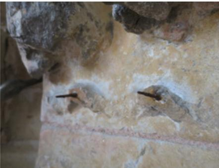
**Fig. 6a.** Pointe de réparation au niveau des bases de voussoir (forme de nuée ou de végétaux)
