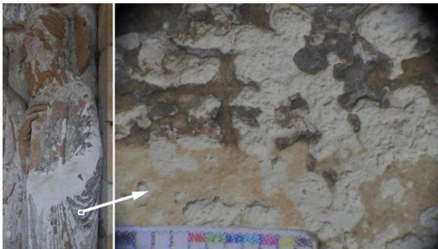
**Fig. 9.** Statue-colonne extérieure de l'ébrasement senestre : en bas à gauche en mode « low Q Switch », le laser respecte l'épiderme que l'essai de microsablage de 2009 avait perforé, mais de tout petits îlots de polychromie ont été éliminés. En bas à droite, le mode « Short Free Running » donne un aspect plus gris, mais respecte les petits îlots de polychromie. © Olivier Rolland
