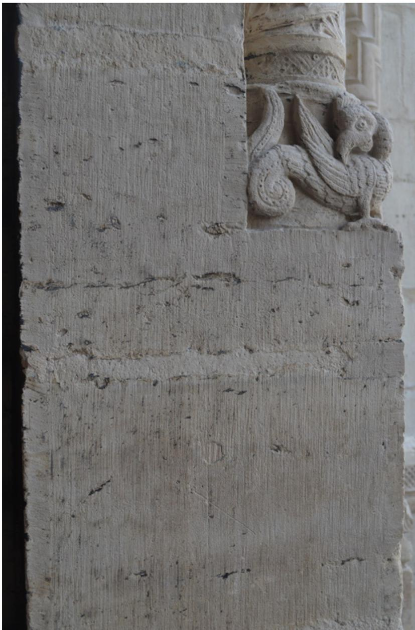
**Fig. 5.** Aspect du parement ravalé par Debret en 1840 sur le piédroit droit du portail sud.
