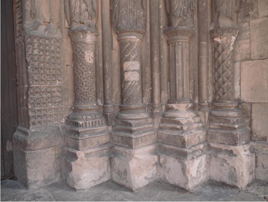
**Fig. 3.** Altérations de la pierre sur l'ébrasement droit (cassures, desquamations, dégradation accrue des bases des colonnes...) et premiers essais de nettoyage par ECMH. Le Mans, cathédrale Saint-Julien, portail royal © Olivier Rolland
