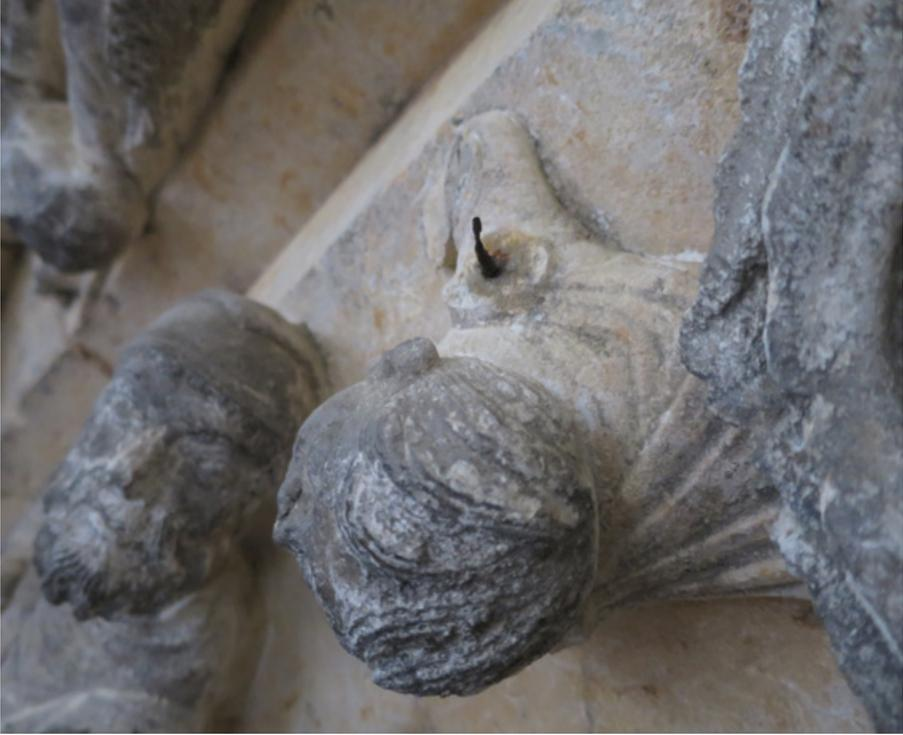
**Fig. 6.** Sculpture d'ange : on observe une surface aplatie et une tige de fer au niveau de l'épaule qui permettait certainement l'ajout d'un volume comme une aile par exemple. Il s'agirait d'un dispositif ancien plutôt que d'une réparation. Le Mans, cathédrale Saint-Julien, portail royal, voussure
