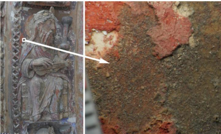
**Fig. 7.** Quatrième claveau du rouleau de voussure extérieur à dextre : le nettoyage réalisé en 2009 a laissé la croûte noire là où l'on devine, au-dessous, l'ocre rouge de la préparation du XVII<sup>e</sup> siècle appliquée directement sur le tuffeau (la mire en millimètres donne l'échelle de la macrophotographie à droite). © Olivier Rolland
