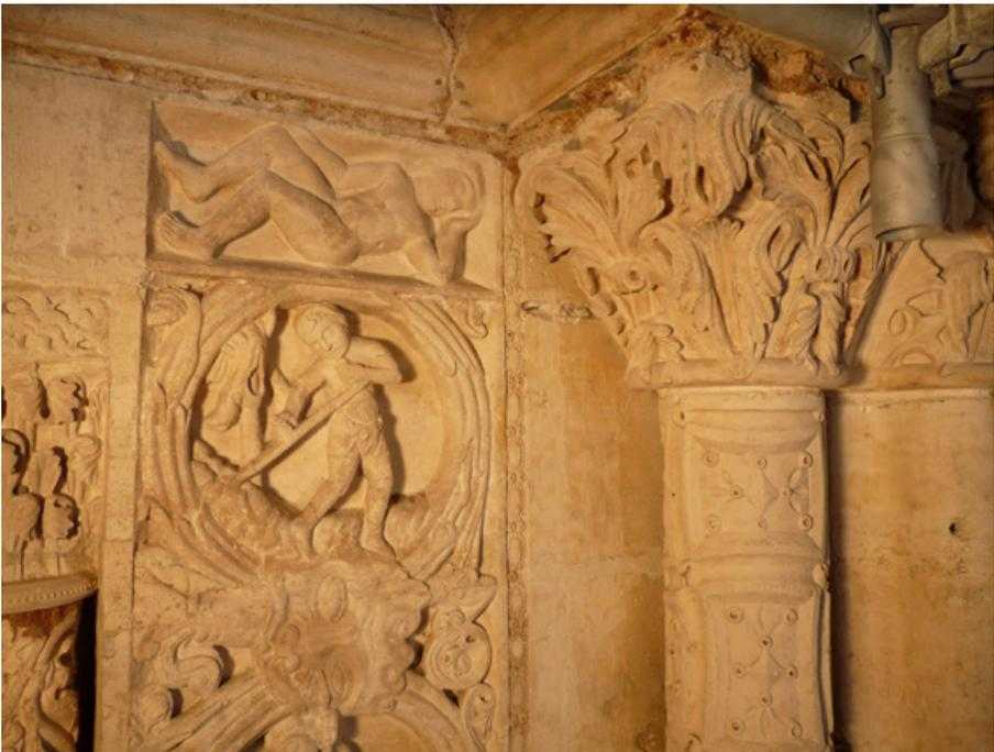
**Fig. 9.** Mois de juin et figure féminine sur le piédroit droit du portail sud. Discontinuité entre le motif de rinceau et le dernier cartouche comme conséquence du travail d'ajustement. (© Photo UASD / M. Wyss)
