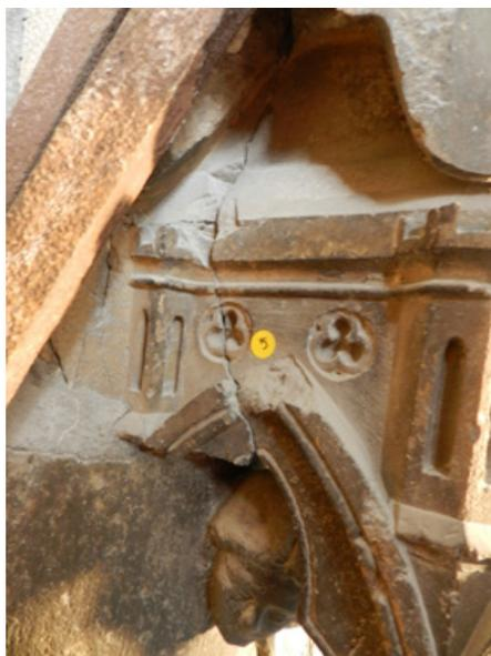
**Fig. 10.** Console de la Vierge de la Présentation au Temple. Cisaillement et morcellement de la console (© Hubert Boursier)
