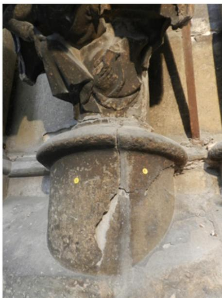
**Fig. 9.** Base du Saint Joseph. Fissures obliques réduisant la surface portante (© Hubert Boursier)
