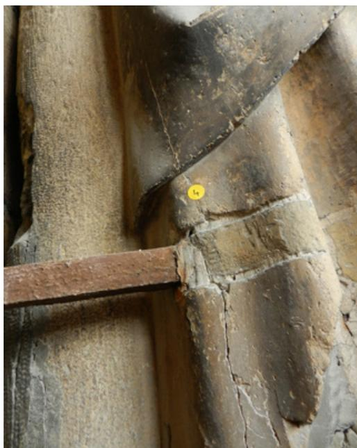
**Fig. 7.** Vierge de la Présentation au Temple, profil dextre. Détail du délitage de la colonne et des plis (© Hubert Boursier)
