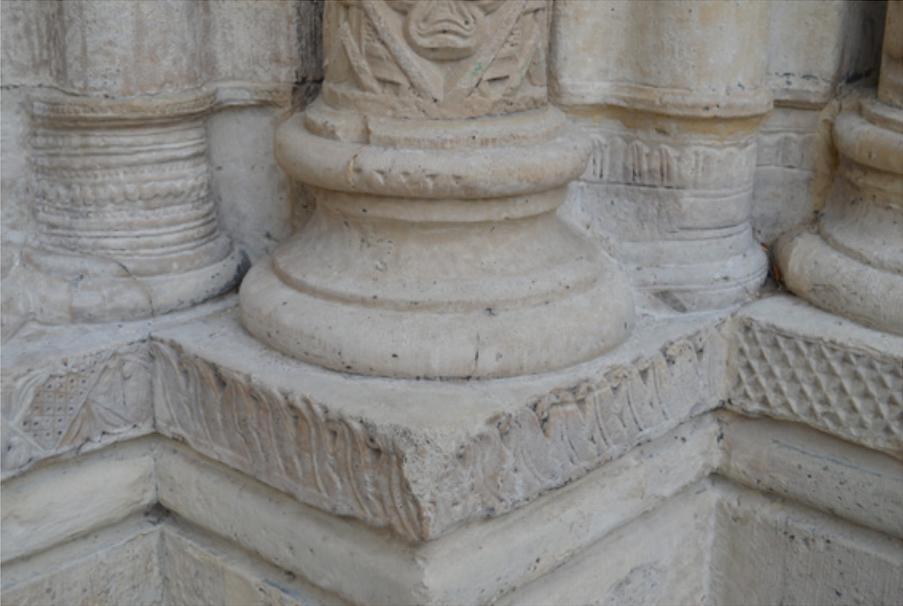
**Fig. 7.** Bases de l'ébrasement droit du portail sud. Base retaillée en profil attique en 1770 avec restes de l'ancien décor mieux préservé sur les bases intercalaires. (© Photo UASD / M. Wyss)
