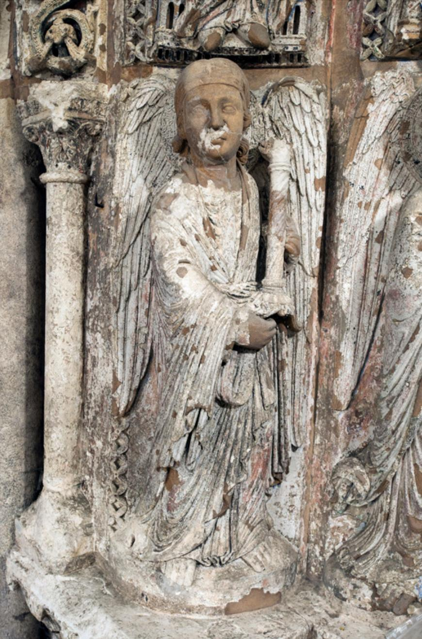
**Fig. 3.** Un ange cérophéaire du premier registre de la voussure extérieure à droite (niveau du linteau) avant restauration. Le visage et le cou ont été restitués par Antoine-Laurent Dantan qui a également fait quelques ragréages. Le ciment « romain » ou « naturel » utilisé pour ces compléments a bruni avec le temps. © Dominique Bouchardon / LRMH
