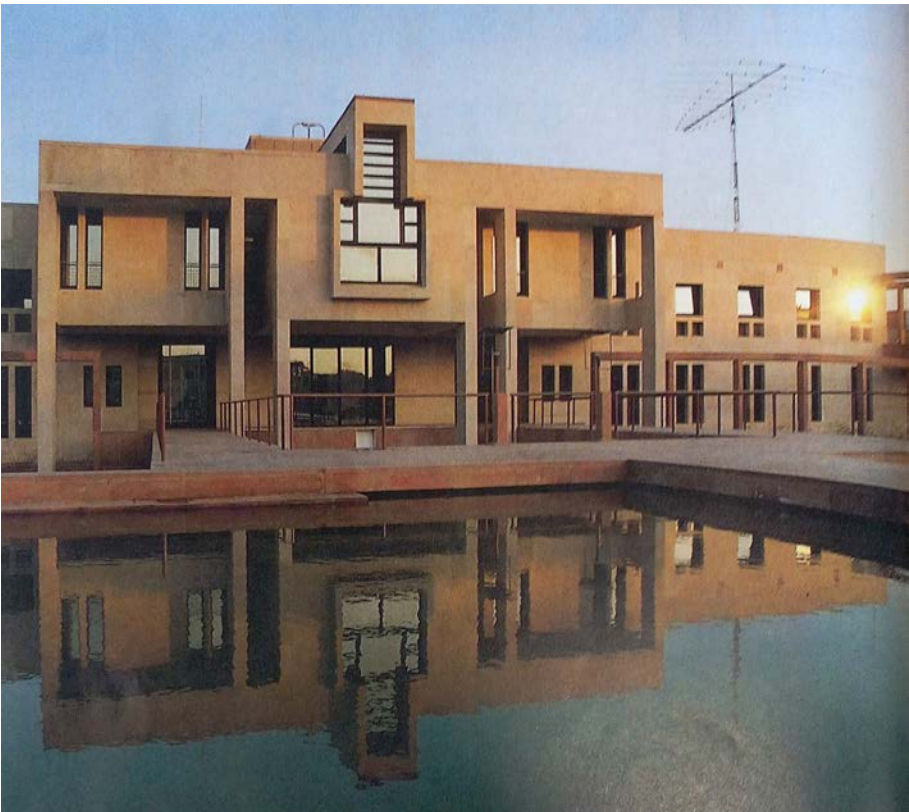
Fig. 6. Décrochés du portique sur jardin de l'ambassade de France à New Delhi (1980-1985, arch. : Paul Chemetov et Borja Huidobro), © L'Architecture d'aujourd'hui , n° 247, oct. 1986, p. 58.
