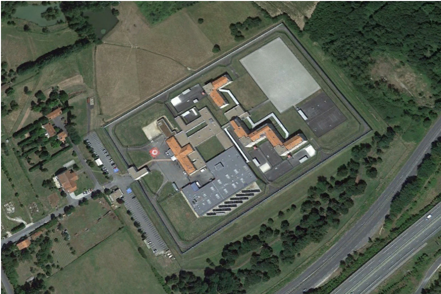
Fig. 2. Vue satellite du centre de détention de Neuvic (Dordogne, 1990, arch. : SERA), source : © Google Earth.
