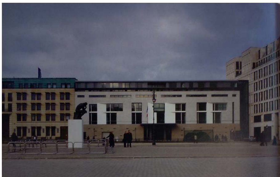
Fig. 2. Façade principale de l'ambassade de France à Berlin (1995-2003, arch. : Christian de Portzamparc), © L'Architecture d'aujourd'hui , n° 346, 2003, p. 40.
