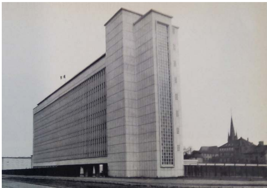
Fig. 1. Façade nord de l'aile administrative de l'ambassade de France à Sarrebruck (1950-1954, arch. : Georges-Henri Pingusson), © L'Architecture d'aujourd'hui , n° 58, 1955, p. 47.
