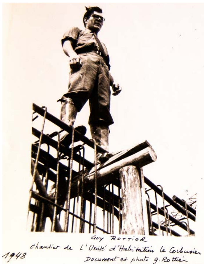
Fig. 2. Guy Rottier lors du ferrailage du sol artificiel de l'Unité d'habitation de Marseille en 1948, Archives privées Odette Barberis-Rottier (© NHE, 2014).
