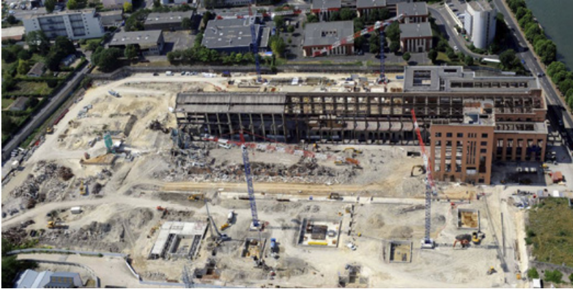
Fig. 5. La reconversion de la centrale électrique Saint-Denis II en Cité du cinéma. Seule la nef centrale est conservée. Photographie Boris Horvat, AFP.
