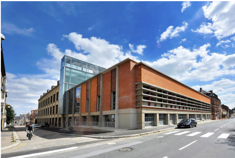
Fig. 4. La Fabrique des Savoirs d'Elbeuf. Droits réservés ( http://www.metropole-rouen-normandie.fr ).
