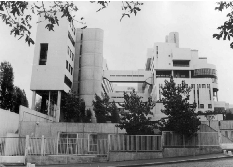
Fig. 3. Vue de la façade Nord-Ouest de l'hôpital Robert-Debré, 1988. Document communiqué par Catherine Blain.
