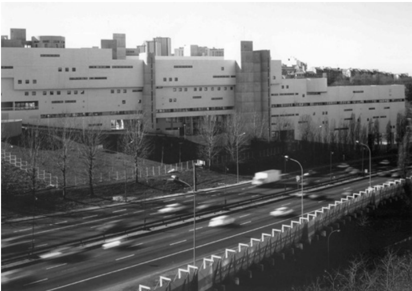
Fig. 4. Vue de la façade Nord de l'hôpital Robert-Debré, 1988. Photographie de Sophie Riestelhuber, document communiqué par Catherine Blain.
