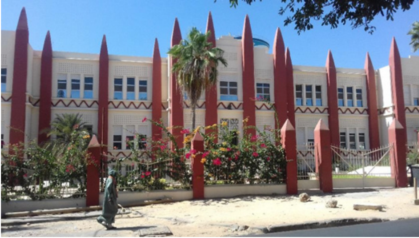
Fig. 3. Maternité Aristide Le Dantec , ancienne Maternité indigène, 2018, Dakar, Sénégal ©Yérïm Thiam Sabine.
