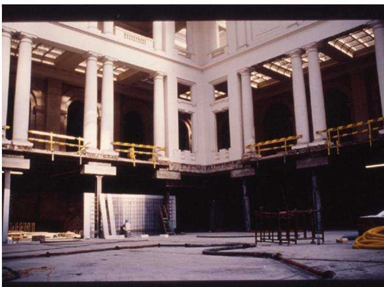
Fig. 5. Piliers de l'atrium mis sur châssis afin de creuser sous le musée durant la rénovation de 1991-1997. © Agence Ibos et Vitart.
