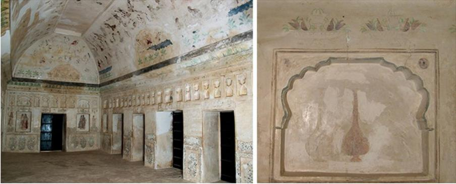
**Fig. 3.** Vue d'ensemble de l'intérieur du palais Sheesh Mahal avant interventions (gauche) et détail des peintures illustrant l'aspect de l'enduit recouvert d'une couche d'oxalate de calcium d'une distribution hétérogène et d'une couleur variant du gris au brun. © The Courtauld Institute of Art
