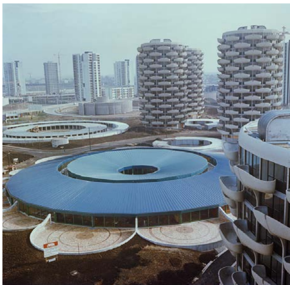
Fig. 3 Photographie du quartier du Palais : chantier d'une des écoles-fleurs (arch. Gérard Grandval), s.n., s.d, Archives privées de Gérard Grandval, Paris, document non coté.
