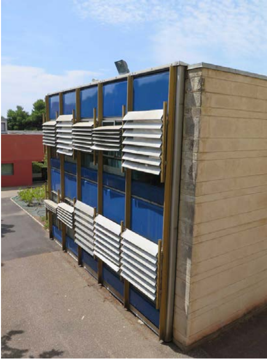
Fig. 1. Lycée Jean-Moulin à Béziers (Hérault) : Murs-rideaux, détail des pare-soleil métalliques à lames horizontales © Michèle François (Drac Occitanie).
