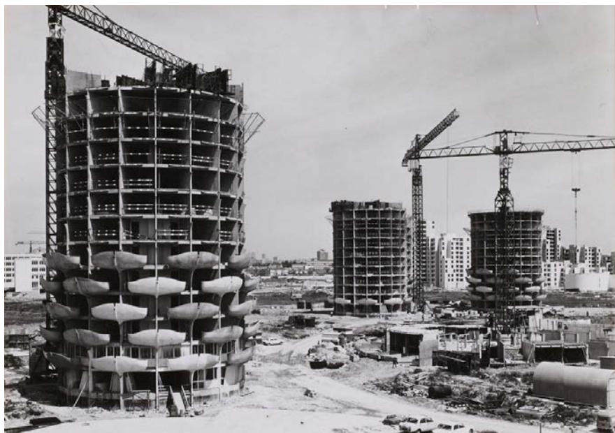
Fig. 2. Photographie du quartier du Palais : Immeubles Les Choux en construction (arch. : Gérard Grandval), 1972, Archives départementales du Val-de-Marne © Jean Biaugeaud, 33F/CRETEIL 319.
