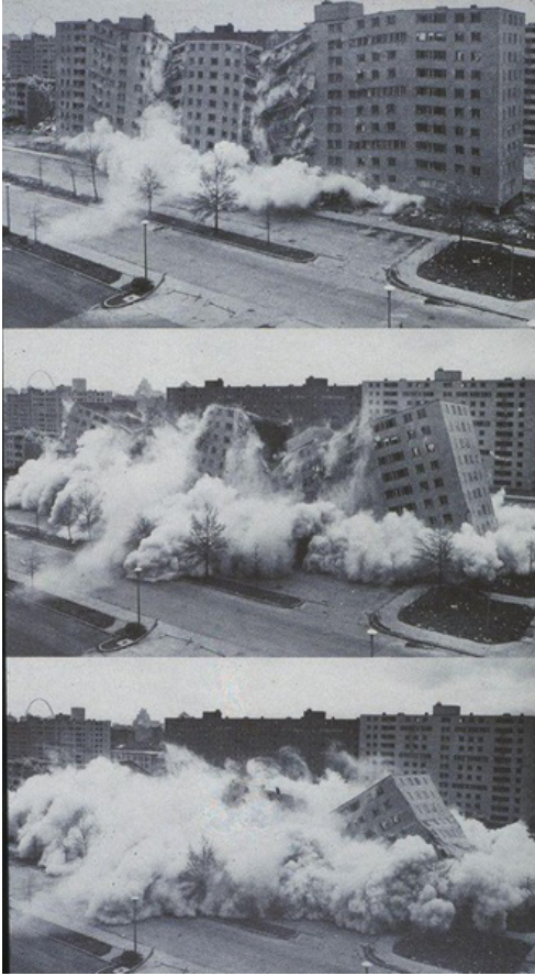
Fig. 3. La première phase de démolition du complexe de Pruitt-Igoe, photographie inconnu © ARTSOR. Source : Saint Louis: Pruitt-Igoe Housing Project: In the Process of Destruction . 1956, demolished 1973. https://jstor.org/stable/community.13563985 .
